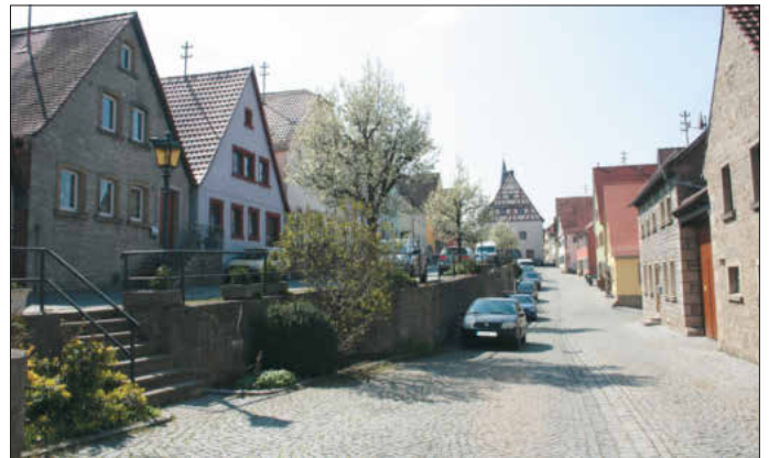
Die Harbachstraße ist aufgrund der Hanglage in zwei Ebenen durch eine mittlere Stützmauer geteilt. Die geschlossene giebelständige Bebauung bildet die historisch gewachsene Raumkante.
