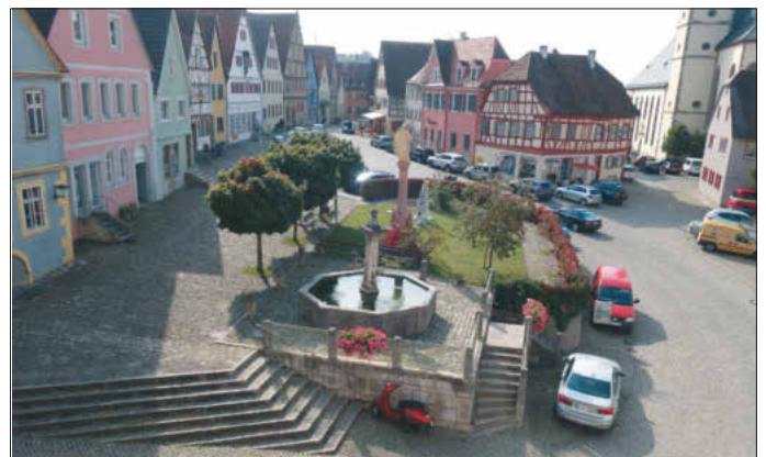
Klar definierte Raumkanten am Marktplatz durch geschlossene Giebelhausreihung. Dem historischen Straßen- und Platzbild der Altstadt Aub kommt eine besondere Bedeutung zu.
