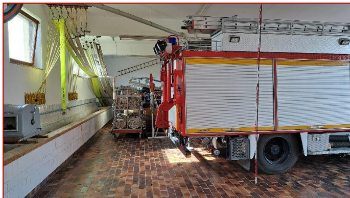
Abbildung XV - Blick in die Fahrzeughalle im Feuerwehrhaus Aub
